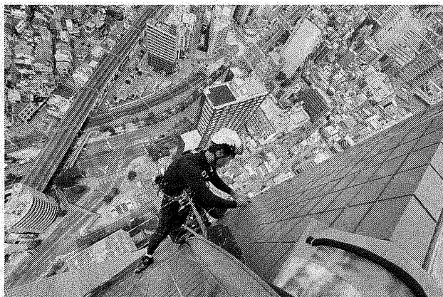
足場を組まずに高所作業ができるロープアクセス。低コストと工期の短縮が期待できる。
